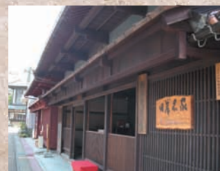
旧岸名家 越前国三國湊で材木商を営んだ、新保屋岸名惣助が代々住んでいた町家。妻入りの正面に平入りの前半分をつけた「かぐら建て」で、水琴窟を備えるなど、三國湊の町家の特徴を多く残しています。
